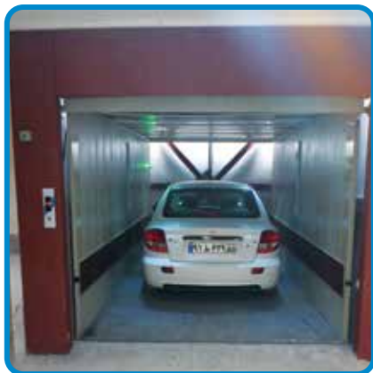
ماشین بر به ارتفاع ۸ متر (جک از زیر مستقیم)
