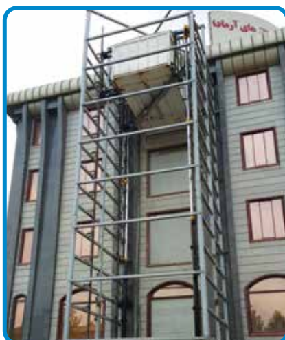
ماشین بر به ارتفاع ۲۰ متر (جک از کنار تلسکوپی ۲ مرحله غیر مستقیم)
